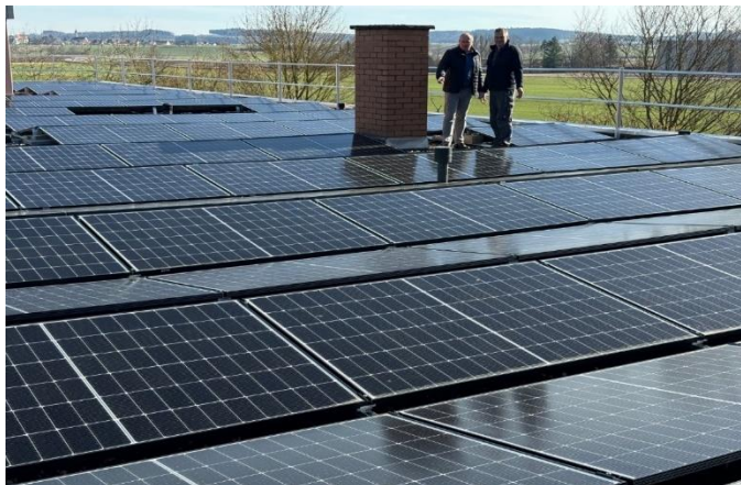
Klärwärter Roland Butz u. BM Karl Hauler besichtigen die Anlage
